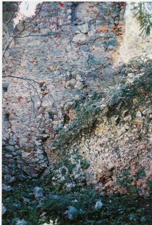
Εικ. 4. Κατακερματισμένοι και αποκολλημένοι ασβεστόλιθοι.
